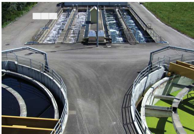
100 von 700 Schweizer Kläranlagen werden in den nächsten 20 Jahren umgerüstet: ARA Opfikon-Glattbrugg. Bild: Urs Keller/Ex-Press
